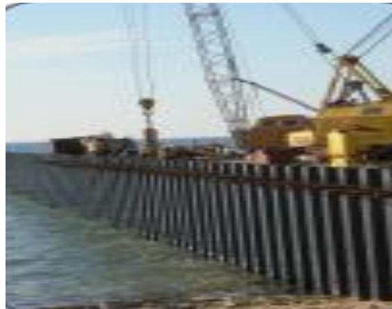
Рисунок 4.3 – Защитные преграды из стальных щитов, возводимые вдоль транспортных коммуникаций и важных предприятий
